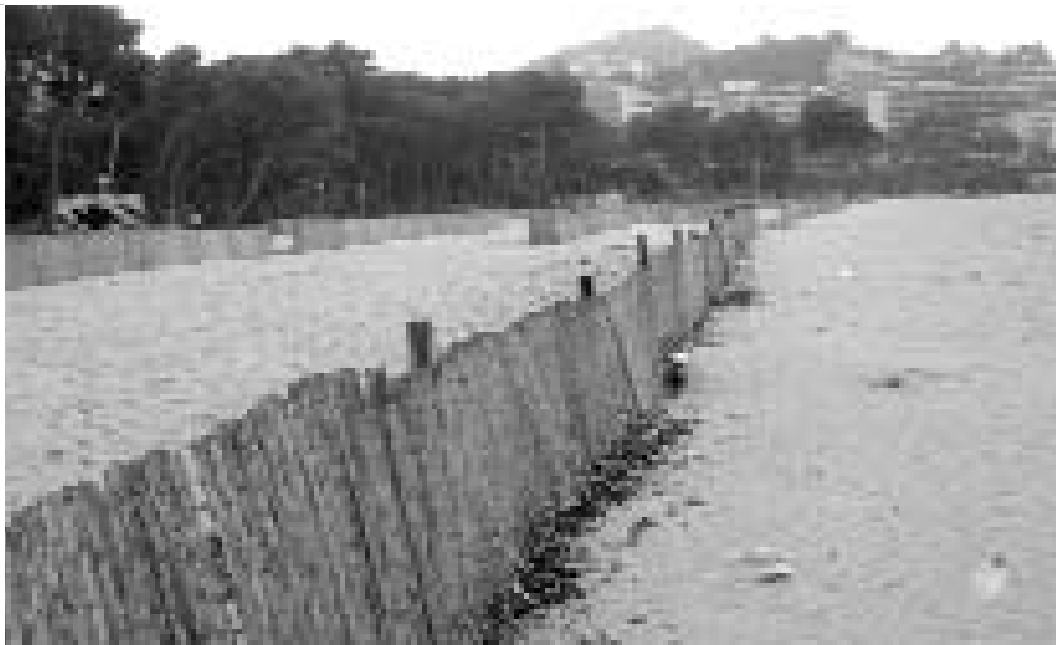
6.8: Cañizos captadores de arena en una playa
