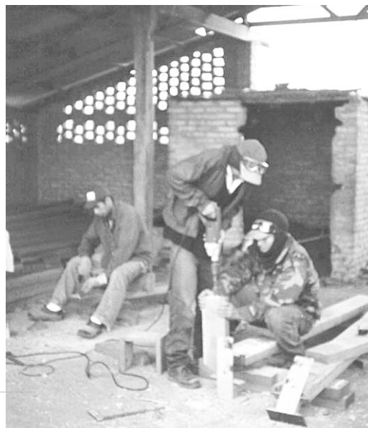
Un dia de treball a l'obra
