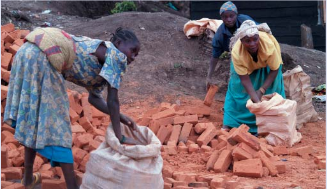
Mujeres trabajando en la construcción, en la República Democrática del Congo.
