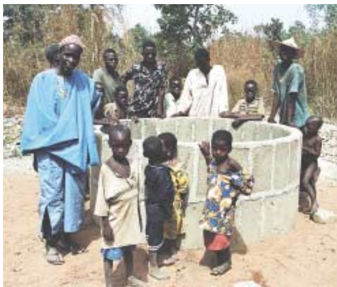
El acceso al agua potable ha sido posible gracias a la construcción de pozos.
