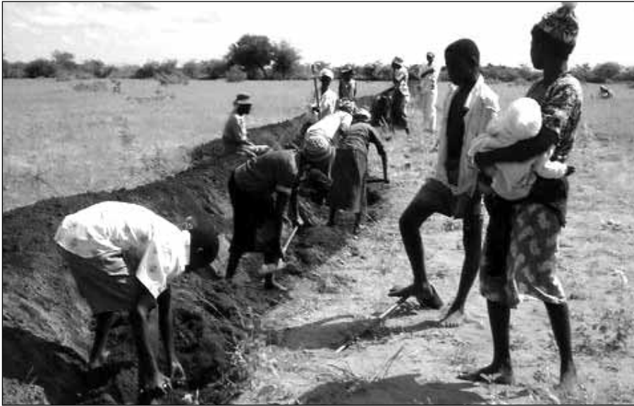
Bordillo ondulado y foso de infiltración en construcción.
