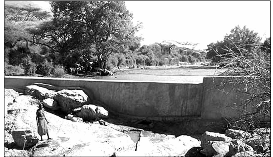
El dique terminado, después de las lluvias.
