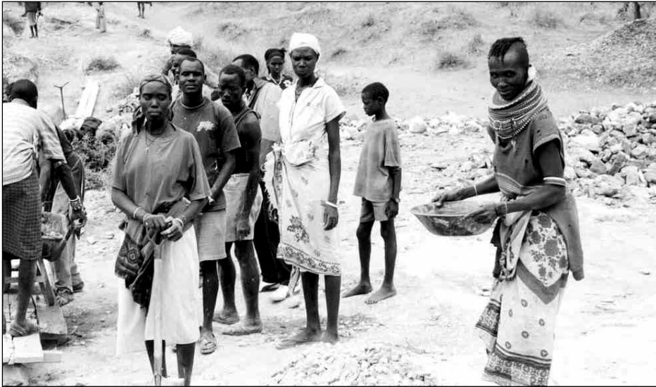
Equipos de mujeres y hombres, samburus y turkanas, trabajando juntos en la construcción de un dique de arena.
