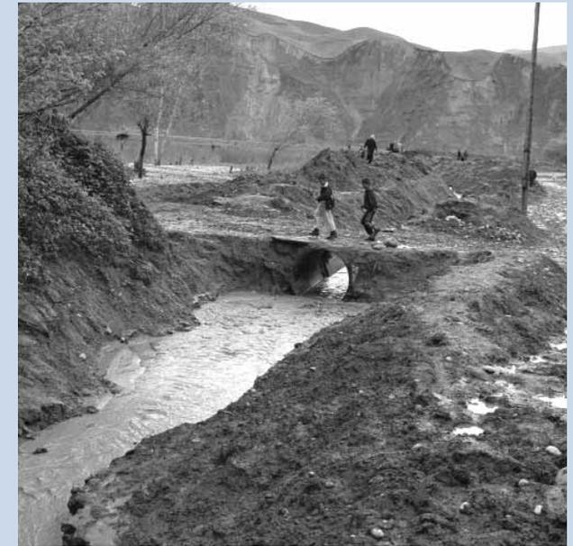
*El pueblo de Shibanaí, Tayikistán, después de 24 horas de lluvia intensa. El canal de drenaje se ha encenagado. Cuando llueve, la obstrucción aumenta el peligro de desbordamiento y riadas rápidas. El agua está filtrándose lentamente por las paredes de las casas. Los charcos con agua estancada atraen a los mosquitos. Oxfam ha pagado una excavadora mecánica para limpiar el canal.*
