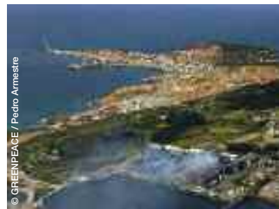
Obras del puerto exterior de Langosteira, en A Coruña.
