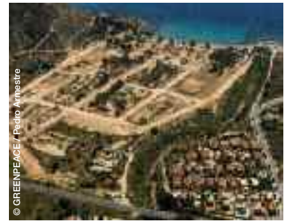
Obras en el frente litoral de Villajoyosa.
