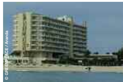
Uno de los hoteles situados en dominio público marítimo-terrestre, en el ENP de las Dunas de Corralejo (Fuerteventura).
