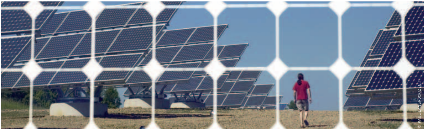
imagen CENTRAL SOLAR FOTOVOLTAICA SOLON AG EN ARNSTEIN: OPERAN 1.500 PANELES "MÓVILES" HORIZONTALES Y VERTICALES, ES LA CENTRAL FOTOVOLTAICA CON SEGUIMIENTO MÁS GRANDE DEL MUNDO.
