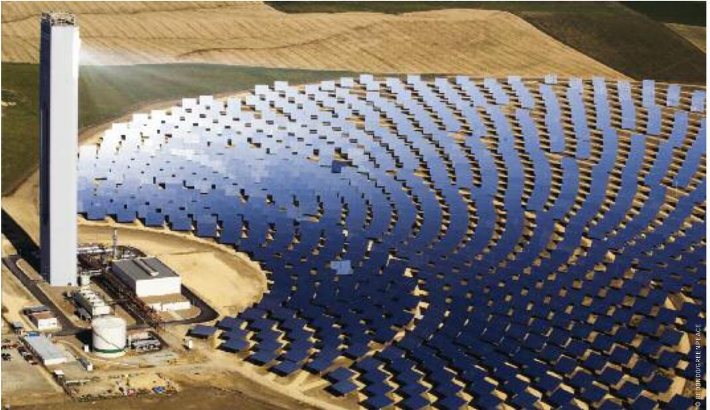
**imagen** FOTO AÉREA DE LA PS10 PLANTA DE ENERGÍA SOLAR TÉRMICA CONCENTRADA. LA TORRE DE ENERGÍA SOLAR DE 11 MEGAVATIOS PRODUCE ELECTRICIDAD CON 624 GRANDES ESPEJOS MÓVILES LLAMADOS HELIOSTATOS. LA PLANTA ES CAPAZ DE PRODUCIR 23 GWH DE ELECTRICIDAD, QUE ES SUFICIENTE PARA SUMINISTRAR ENERGÍA A UNA POBLACIÓN DE 10.000 HABITANTES.
