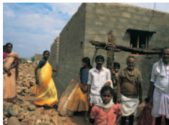
Construcción de casas en una comunidad dáltit.
