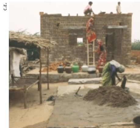
CADA FAMILIA PARTICIPA ACTIVAMENTE, CON LA AYUDA DE FVF-RDT, EN LA CONSTRUCCIÓN DE SU VIVIENDA.
