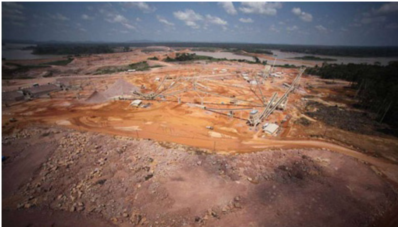
Vistes de les obres de construcció de la hidroelèctrica Jirau. Inici del formigonat al desembre de 2009 (Font: BIC 2010b)
