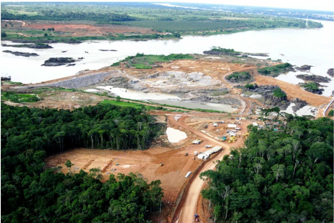
Vistes de les obres de construcció de la hidroelèctrica Santo Antônio (Font: BIC 2010a)
