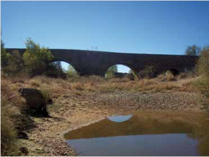
Puente y charcas intermitentes en el entorno de Las Arenosas. Agosto 2014
