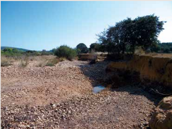
Talud formado por la dinámica erosiva del río. Septiembre de 2014
