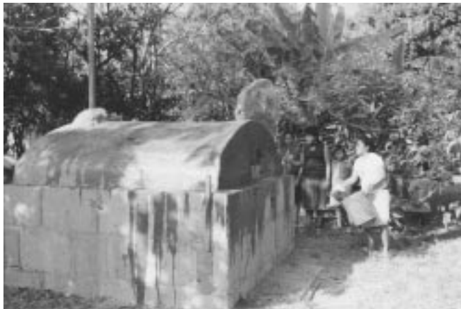
Construcció d'un forn de pa a Nicaragua
