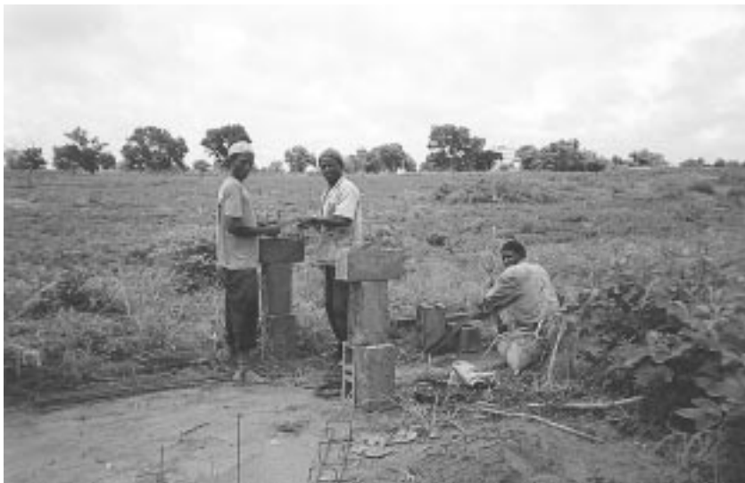
Construcció d'infraestructures bàsiques a Gàmbia.
