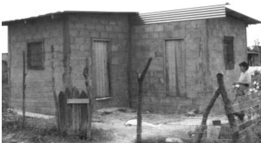
Vivienda construida en el Departamento de Cortés, Honduras.
