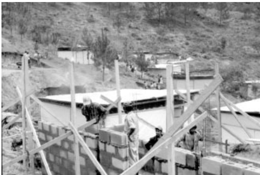
Construcción de viviendas en Dipilto, Nicaragua.
