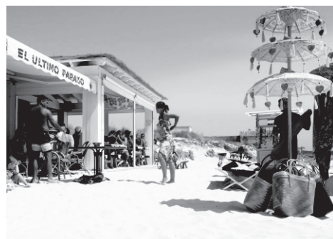
La construcció d'edificis a damunt les platges, com els xibius del Trenc a Campos, genera un retrocés i pèrdua de sediments important.
