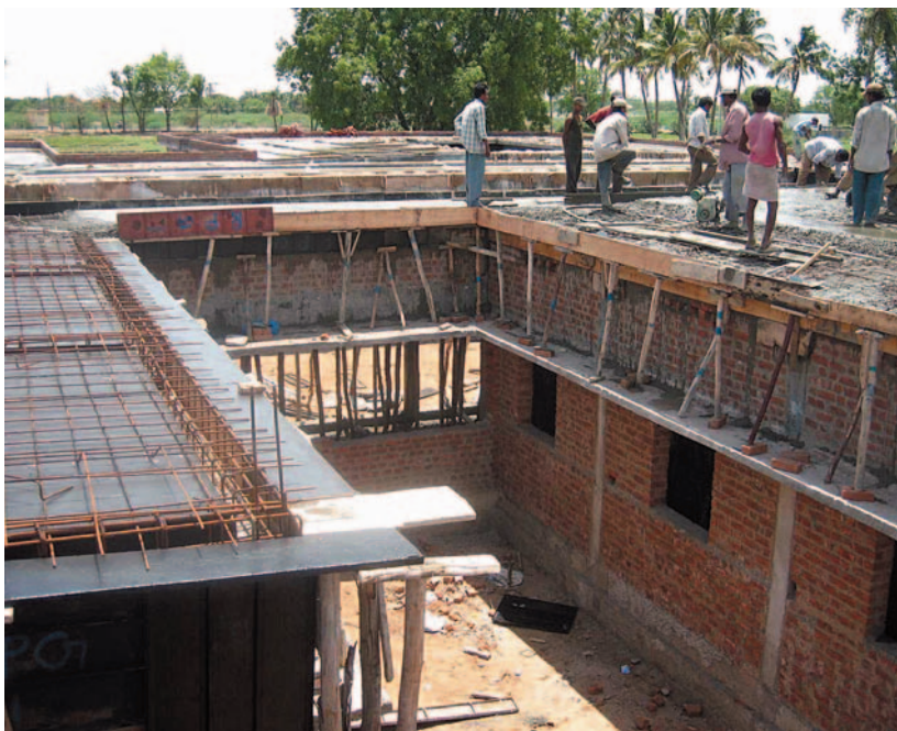
Exterior del edificio FVF
