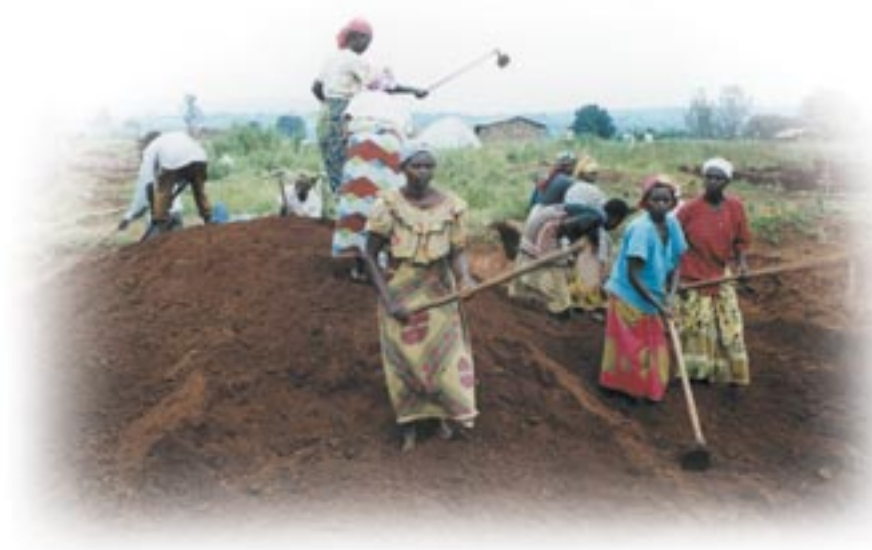
1. Construcció d'habitatges a Rwanda.
