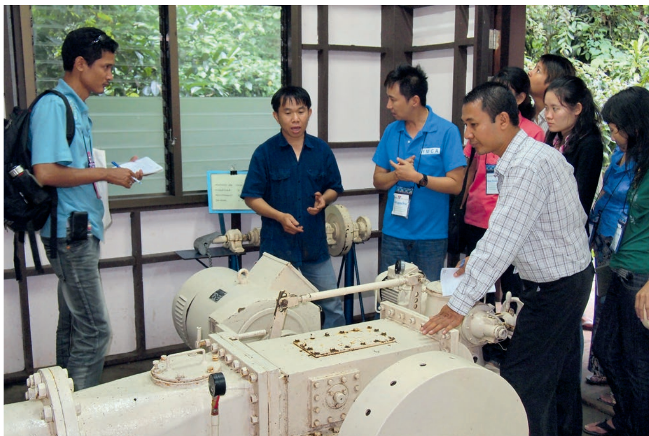
Entender una planta de energía hidroeléctrica: visitantes de Myanmar aprenden cómo funciona un fuente de energía renovable descentralizada en el pueblo de Mae Kam Pong, Tailandia.
