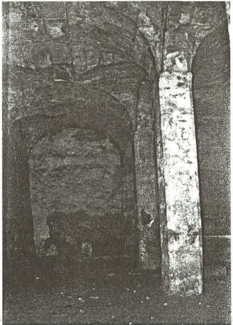
Antic celler de Son Jaumell, està excavat dins marès i aprofitant, parcialment, una cova d'enterrament.
