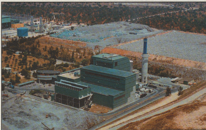
Incineradora i abocador de Son Reus, Palma
