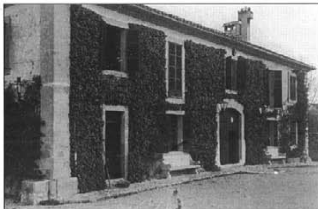
Son Collell: façana tota coberta d'heura
