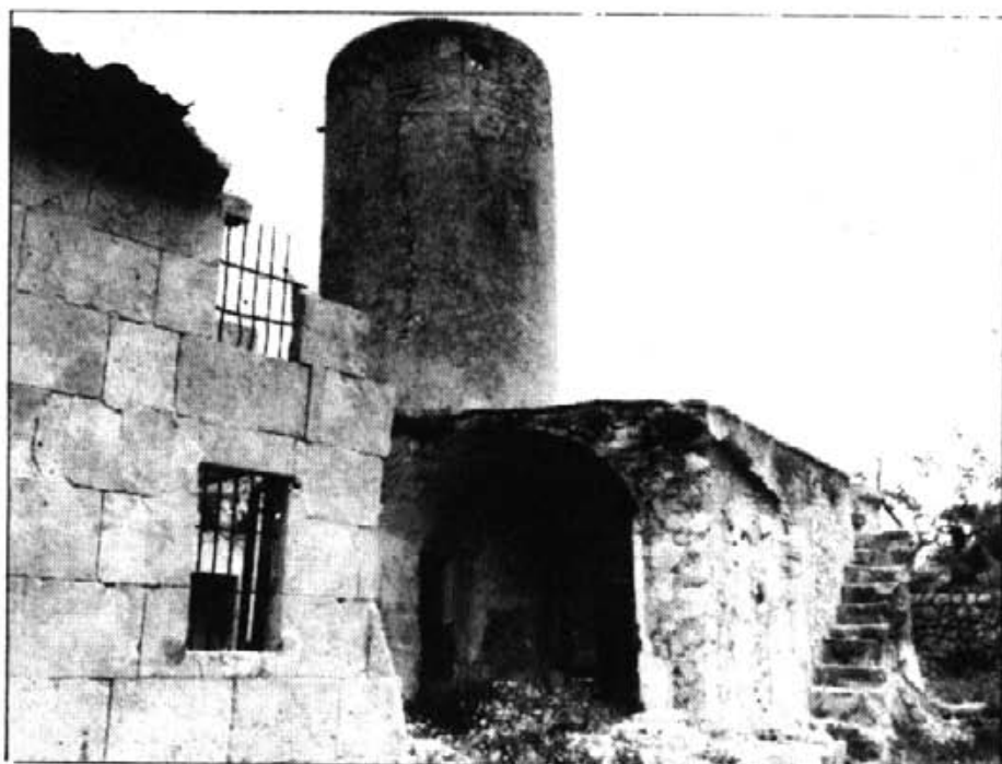
Està previst que la restauració del Molí des Fraret comenci aquest octubre
