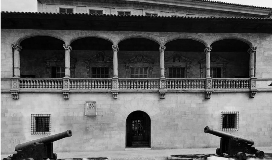
Fig. 1 Palma, Consolat de Mar. Façana marítima, 1614-1624. Detall de la balconada
