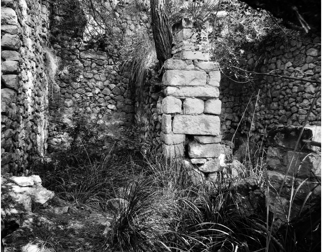
Fig. 8 Forn de guix de la pedrera de Bendinat (Palma). Es poden observar els dos forns amb la paret central d'1 m de gruixa que els separa. Al forn de l'esquerra es pot observar una finestra a la part alta de la paret posterior. En primer terme i a la dreta, es pot observar el que queda de la columna que hi havia a la façana. Fotografia realitzada el 01-05-2016
