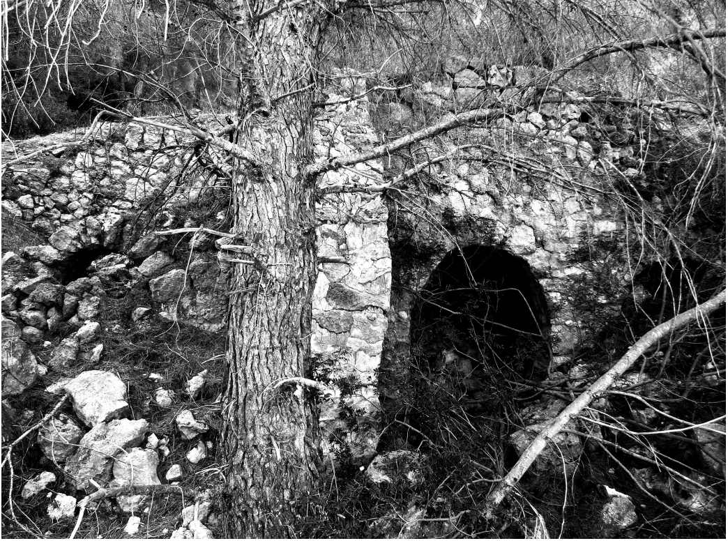
Fig. 3 Forn de guix interiors de les mines de les coves del Pilar (Palma). Cada forn tenia dos portells. Fotografia realitzada el 02-06-2016
