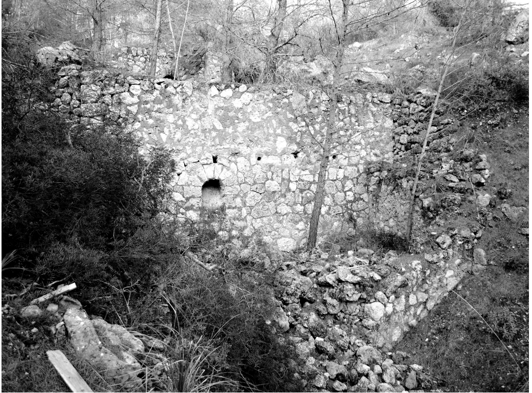
Fig. 4 Finestra de la tremuja dels forns de guix inferiors de les mines de les coves del Pilar (Palma). Per sobre, es poden observar els encastaments de les bigues. Fotografia realitzada el 28-01-2013
