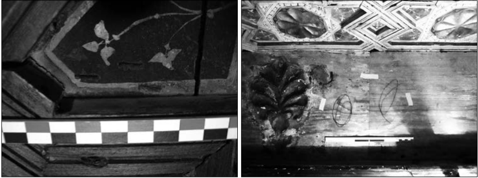
Fig. 9 Diferentes marcas indicativas del trabajo de la recolocación del artesanado mudéjar
