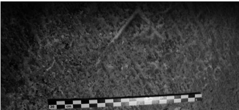
Fig. 3 Marca de cantería en la primera columna de la nave del lado de la Epístola
