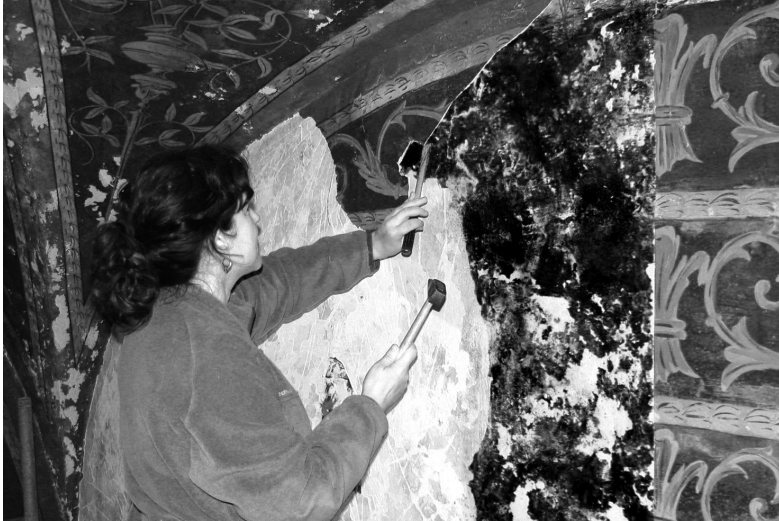
Fig. 10 Retirada de la intervenció de 1969
