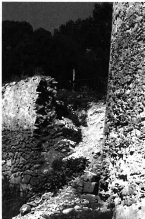
3.- Mur de contenció de l'estrada encoberta del castell de Bellver (oest).
