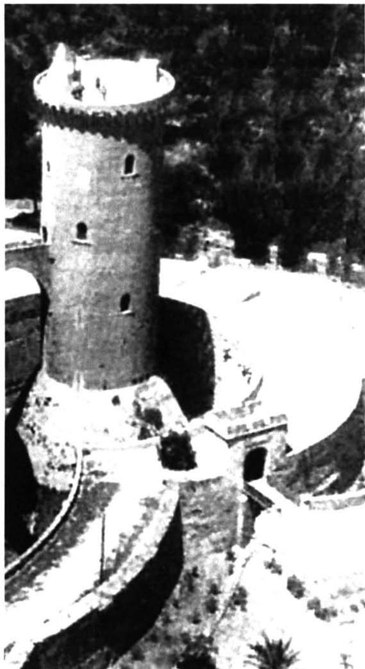
23.- Accés al revellí del castell de Bellver abans de la construcció de l'actual escala perpendicular (J. Mascaró Pasarius ed., Historia de Mallorca ).
