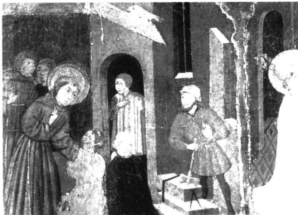
a.- Predela de san Bernardino de Siena y san Bernardo de Claravall. Atribuida a Rafel Mòger. Compartimento dedicado a san Bernardino, representando la resurrección del albañil caído del andamio. Sacristía de la parroquial de S'Horta.
