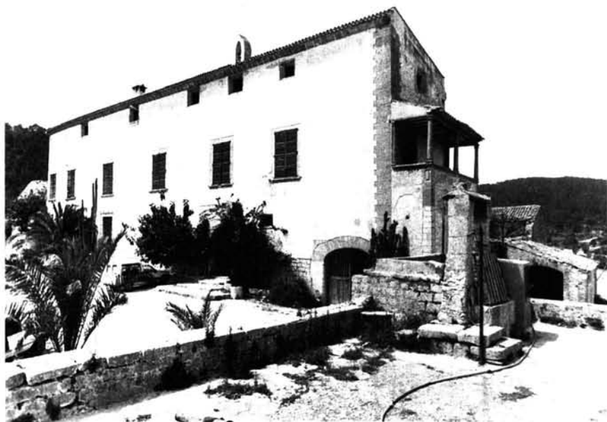
Lámina 1, a.- La façana posterior de Santa Eulàlia a l'actualitat.
