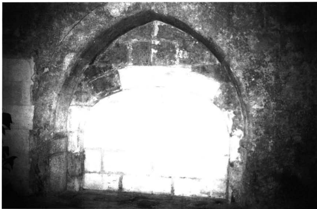
Figura 1.- Emplaçament original del lavatori del convent de Santa Anna de Muro. Estat actual (Fotografia Pau Mateu).
