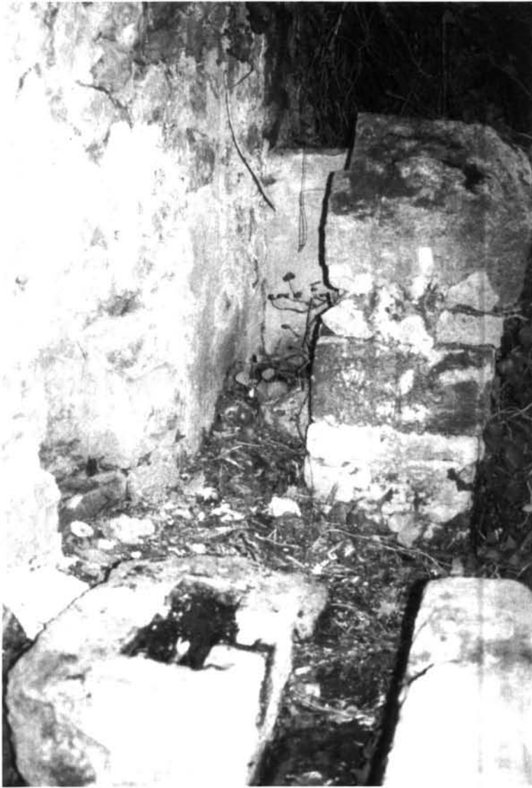
Fotografia 1. El pilar que hi ha en segon pla suportava un dels extrems de l'eix de la roda vertical. El mitjà que hi ha entre el pilar i la paret és modern, en aquest espai voltava l'engranatge principal. A l'esquerra, a la paret s'aprecia el nínxol on girava l'eix de transmissió. En primer pla l'ancoratge de l'eix del moló. 1996.
