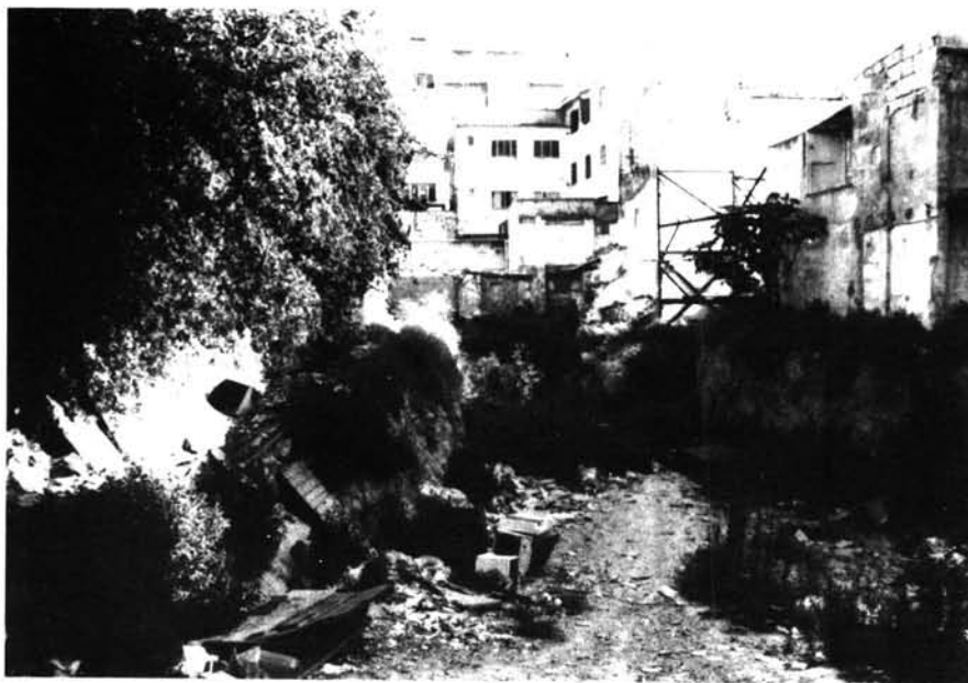
Fot. 1. Vista general del solar des del Carrer de Can Burgos.
