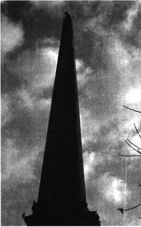
Fig. 3.— Per les lleis de l'entropia, tot monument té tendència natural a degradar-se, de manera que necessita restauració. El monument del Passeig des Born a Ciutadella mostra una clara erosió diferencial, més intensa a la cara Sud-Oest (Foto M. Morey).
