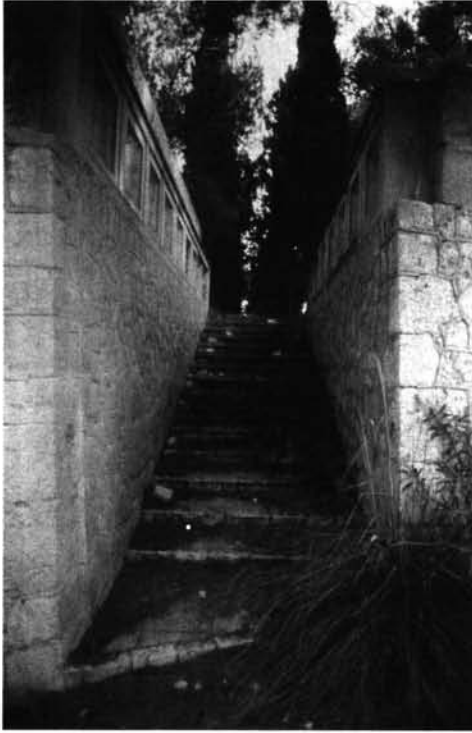
Fig. 8.- Escalinata de acceso a las construcciones y jardines anexos.
