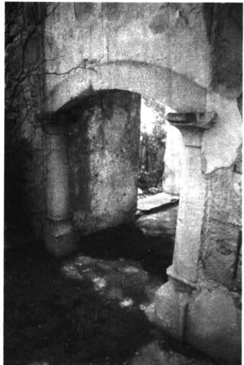
Fig. 9.- Pórtico de una de las viviendas.
