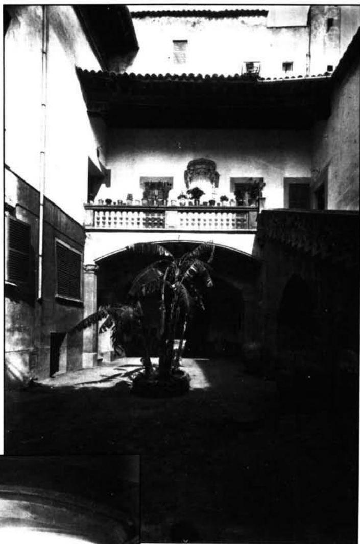
Figura 10: Aspecto general del patio de Casa Oleo.
