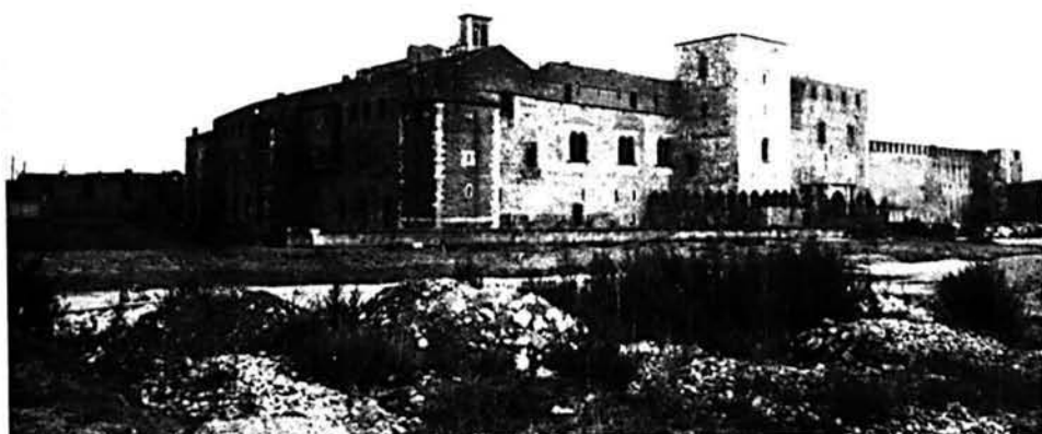
Château royal de Perpignan au début des travaux de restauration. Cliché J. Comet.
