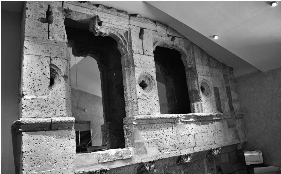
Fig. 4 Palma, Consolat de Mar. Restes del finestram gòtic d'un edifici preexistent
