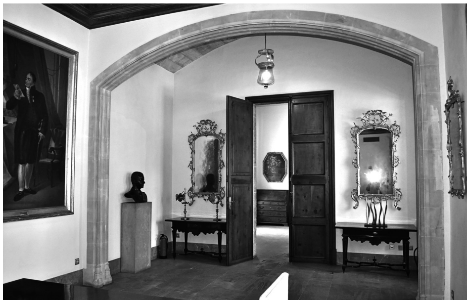
Fig. 7 Palma, Consolat de Mar. Arc escarser amb motlluratge encara gòtic, que separa el vestíbul de la sala de juntes, 1614-1615
