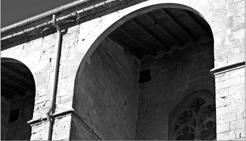
Fig. 6 Detall de l'església parroquial de Petra on es veu la teulada afegida damunt els contraforts mitjançant arcs de mig i l'augment de l'altura de la façana lateral i de part dels contraforts
