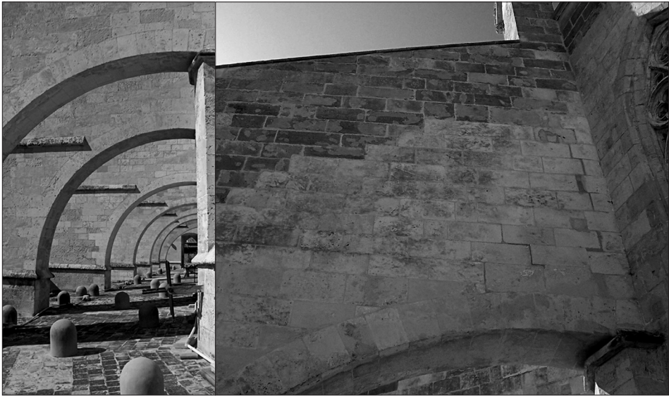
Fig. 4 Contraforts diafragmàtics de la banda de llevant de Santa Eulàlia de Palma vists des de la girola
