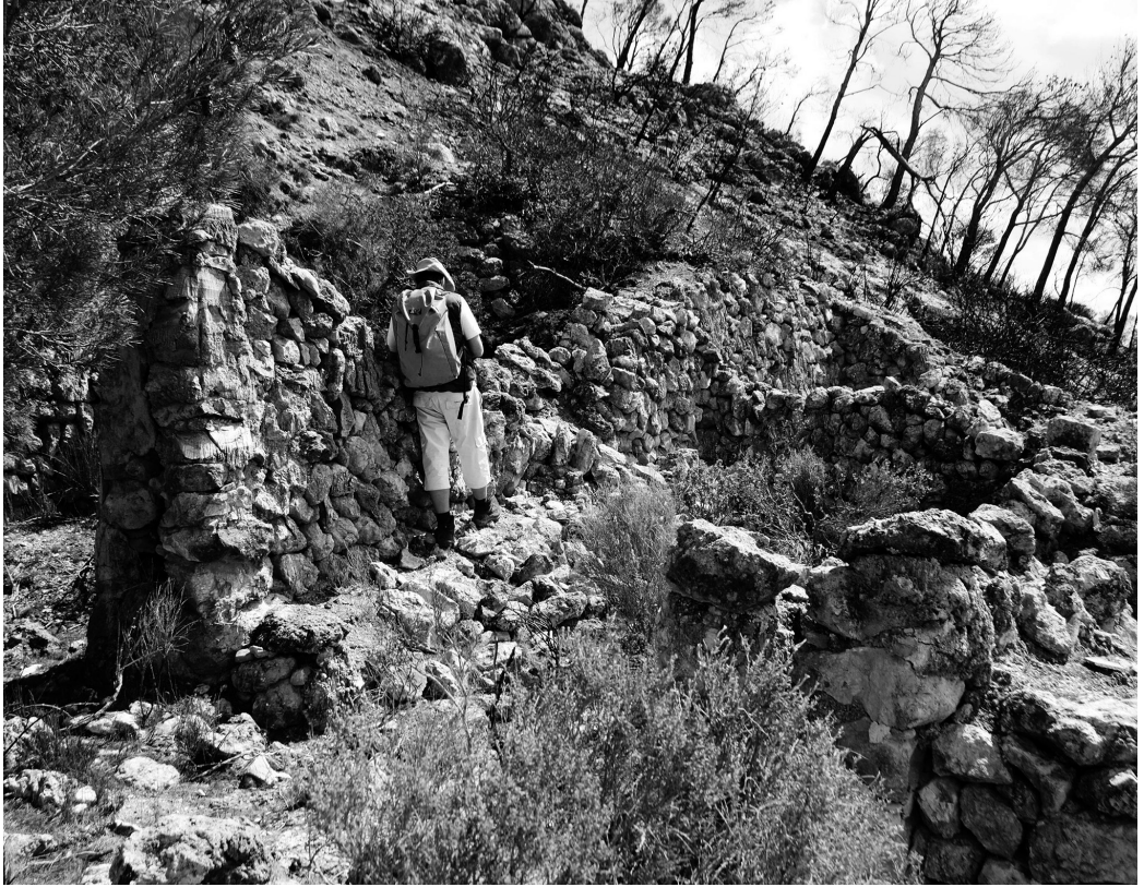
Fig. 10 Forn de guix de na Dalmáu (Calvià), on es pot observar l'estat actual del seu deteriorament. Fotografia realitzada el 06-04-2013
