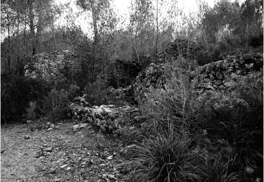
Fig. 5 Vista general dels forns de guix de la pedrera Grossa (Palma), on es pot observar el deteriorament actual. Fotografia realitzada el 03-02-2013
