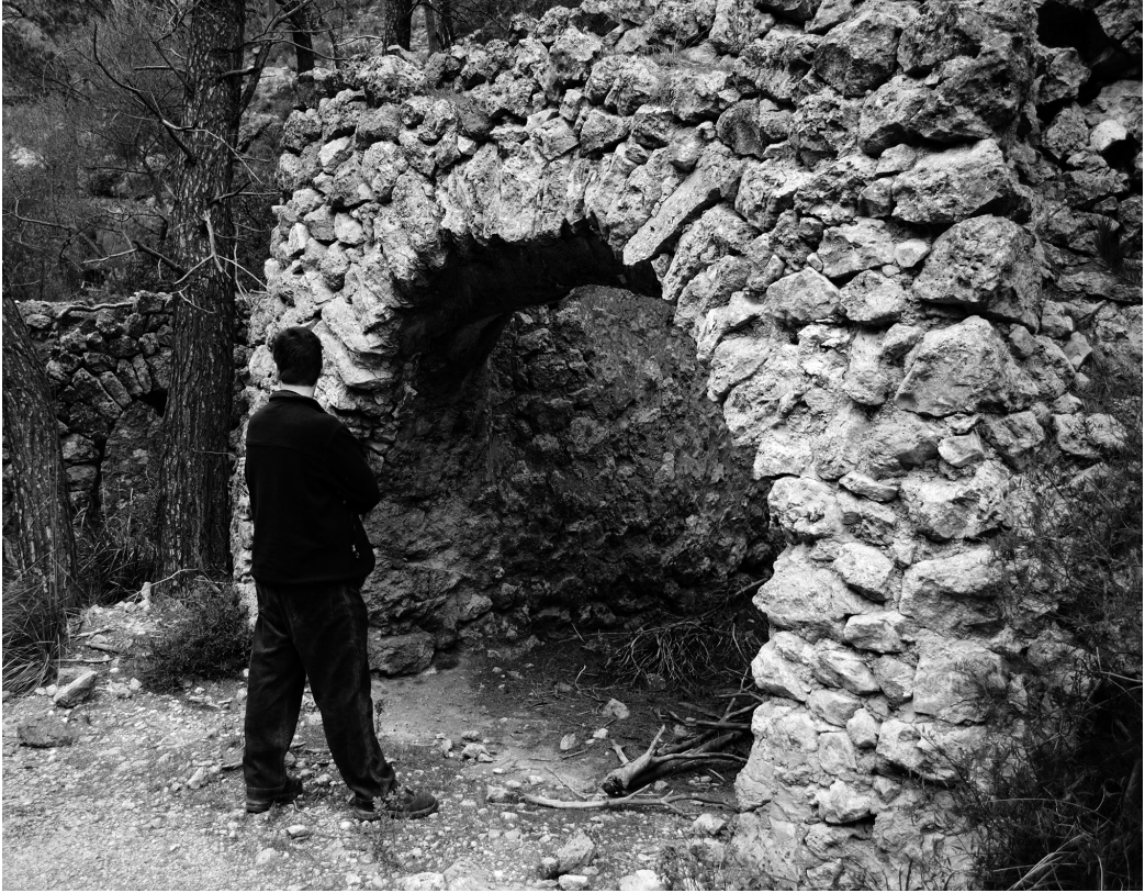
Fig. 9 Forns de guix de la coma de n'Àliga (Calvià). Un presenta una planta quadrangular i una façana amb un arc de mitja volta. L'altre forn és un forn de calç readaptat per coure guix. A la fotografia, a l'esquerra del model, es pot observar una obertura lateral feta al forn de calç. Fotografia realitzada el 19-01-2013
