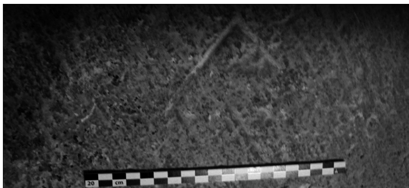
Fig. 3 Marca de cantería en la primera columna de la nave del lado de la Epístola
