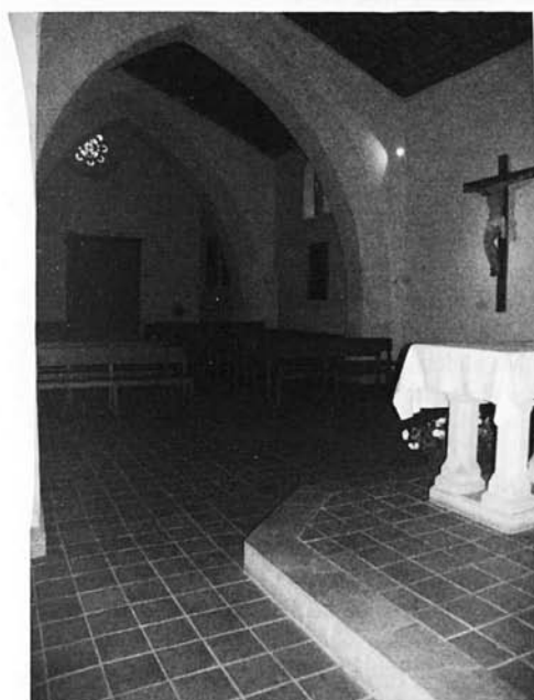
Fig. 10. Imatge actual de l'interior, on es constaten els acabats actuals.
