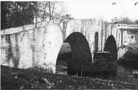
Figura 7.- Pont de Colloto (Astuiras) vist aigües amunt
