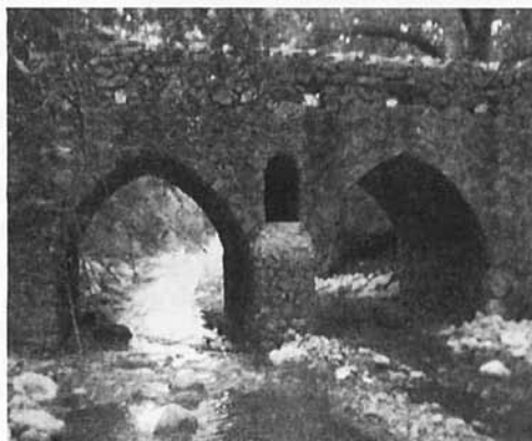
Figura 2.- Pont medieval al torrent de Ternelles
