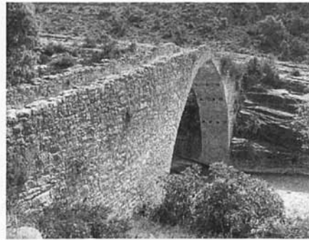
Figura 5.- Pont de Roda
