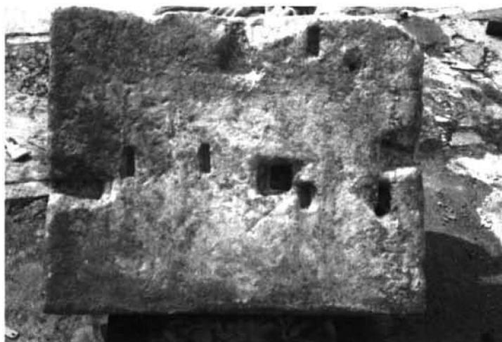
Ello permitió examinar a fondo la pieza y evaluar que las dimensiones reales exteriores del paralelepípedo de piedra son 94 x 76 cm de base por 33 cm de alto<sup>9</sup>. El vaciado para la transformación en pila se realizó dejando un grueso perimetral de 8 cm<sup>10</sup>. La pieza presenta diversos orificios circulares para la evacuación del agua.
