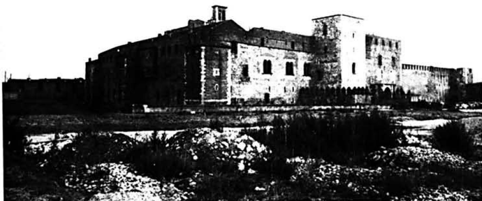
Château royal de Perpignan au début des travaux de restauration. Cliché J. Comet.
