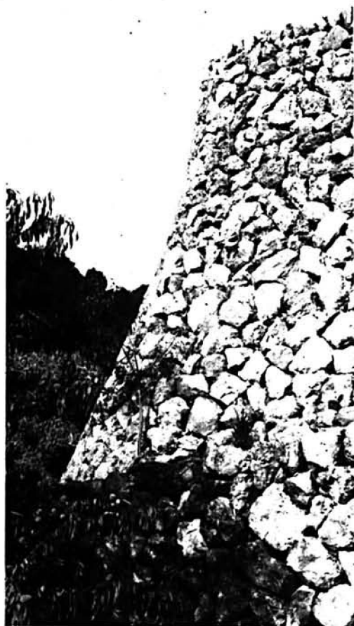
5.- Detall constructiu del trencat del marge .
