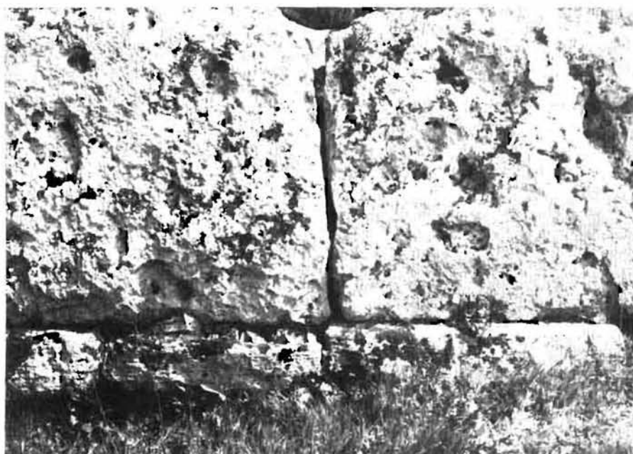
Paramento externo y detalle del mismo.
