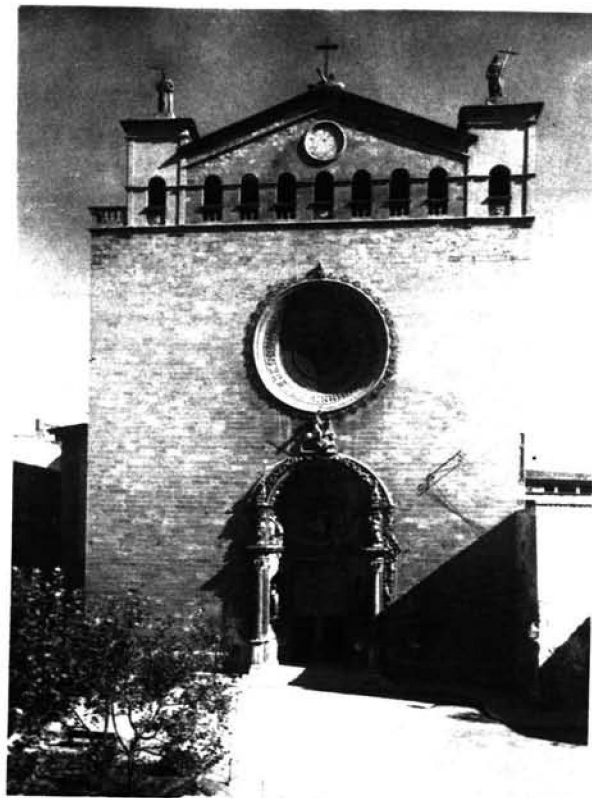
Fachada de la basílica de San Francisco de Palma. Vista general.
