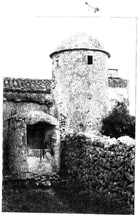
Torre septentrional de Sa Punta.
