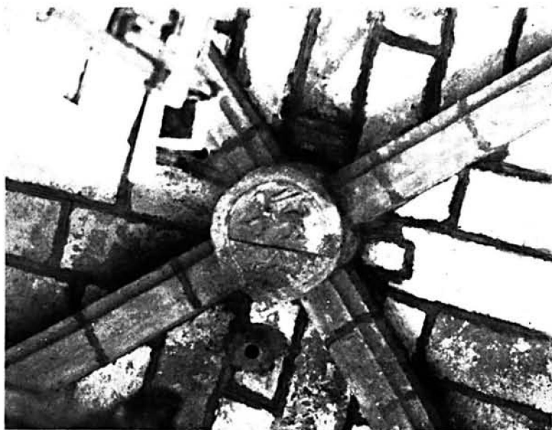
Clave de bóveda de la «Cambre de les campanes», con la fecha de 1665. Foto J. Juan.
