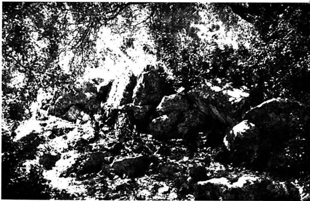
Paramento exterior del monumento navetiforme aislado de Baix des Llisar (Canyamel), Capdepera. (Véase plano en la página 279). - Foto: J. M. P.
