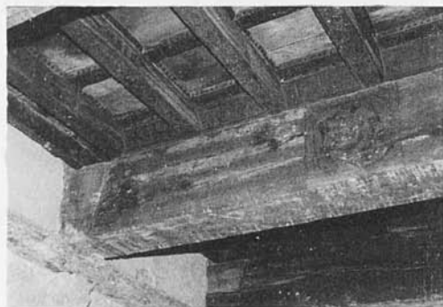
Foto 2. Vista parcial del artesonado con la disposición de las cartelas (Sant Gaietà 5).
