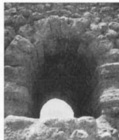
Figura 18.- Arc de descàrrega sense clau i amb dues contraclaus de poc gruix
