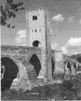
Figura 3.- Pont de Frias (Burgos)
