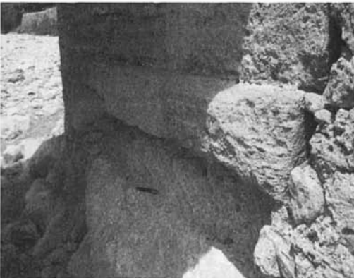
Figura 16.- Entalladura a la base de fonamentació
