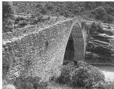
Figura 5.- Pont de Roda
