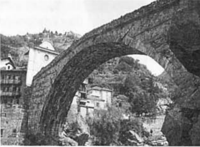
Figura 6.- Pont de sant Martí d'Aosta
