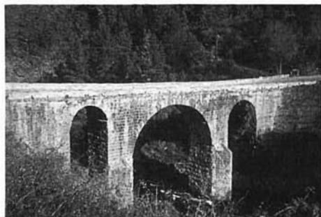
Figura 9.- Vista aigües amunt de A Ponte Bibei (Ourense)
